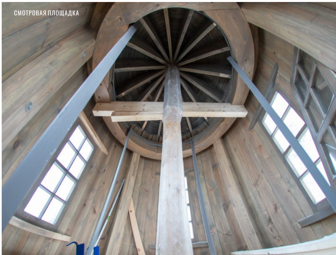
КОНСТРУКЦИЯ ПЕРЕКРЫТИЯ 3 ЯРУСА
